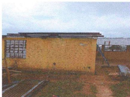
Foto 3: Se puede observar que ya se está trabajando en el mantenimiento de la estructura portante para luego colocar la cubierta nueva.
