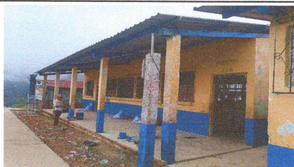
Foto 1: Se puede observar ya trabando en las mejoras de la estructura portante.
