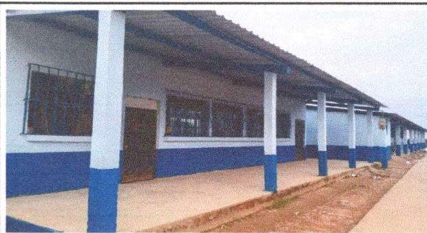
Se puede apreciar ya la aplicación de pintura en un 80 % al igual que la colocación de vidrios nuevos.
